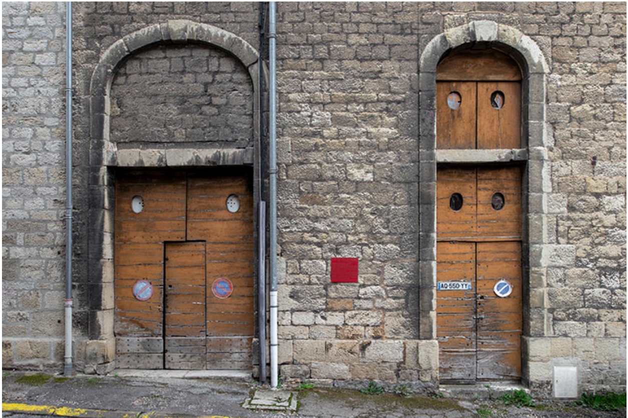
Façade sur rue. Portes des travées sud.
