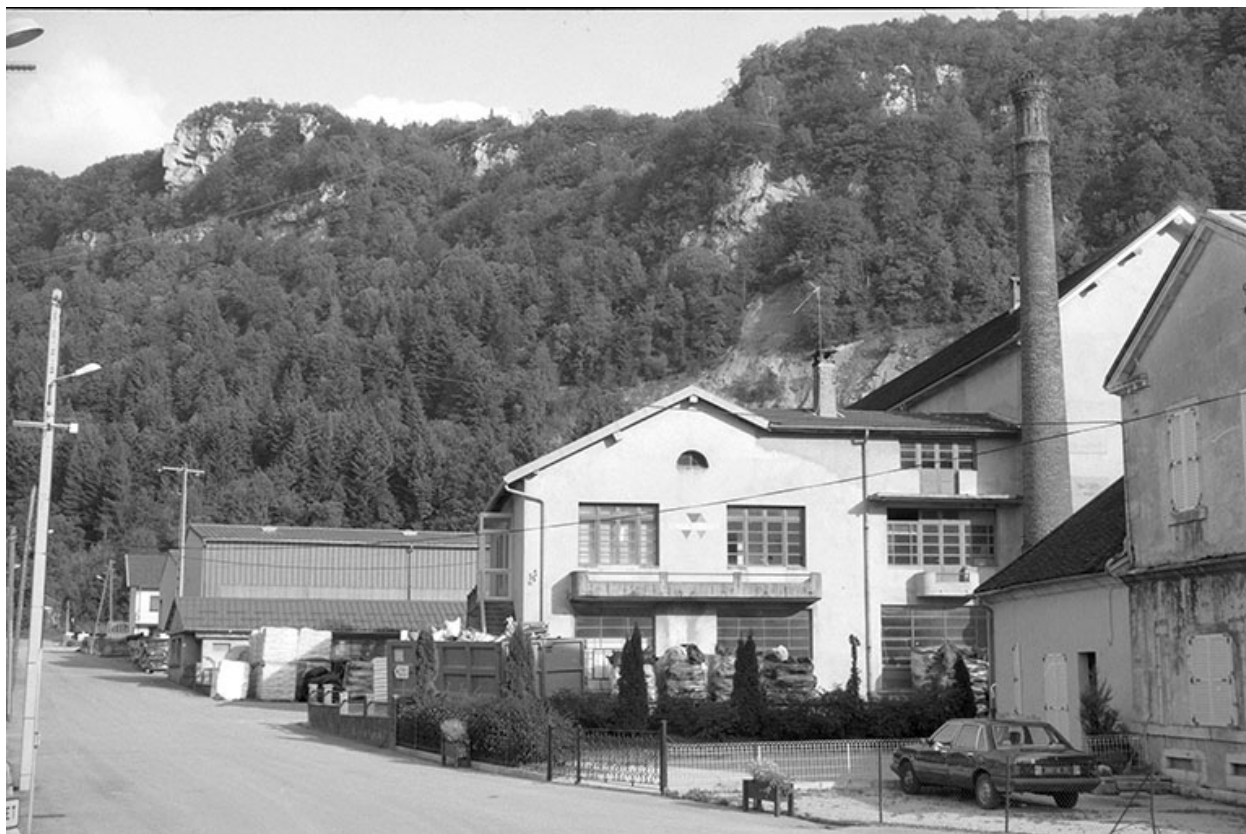
Bureau, entrepôt industriel et cheminée d'usine.
