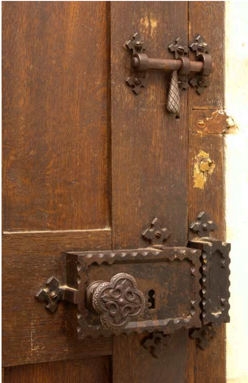
Bâtiment du réfectoire : poignée de porte, serrure et loquet néo-gothique.
