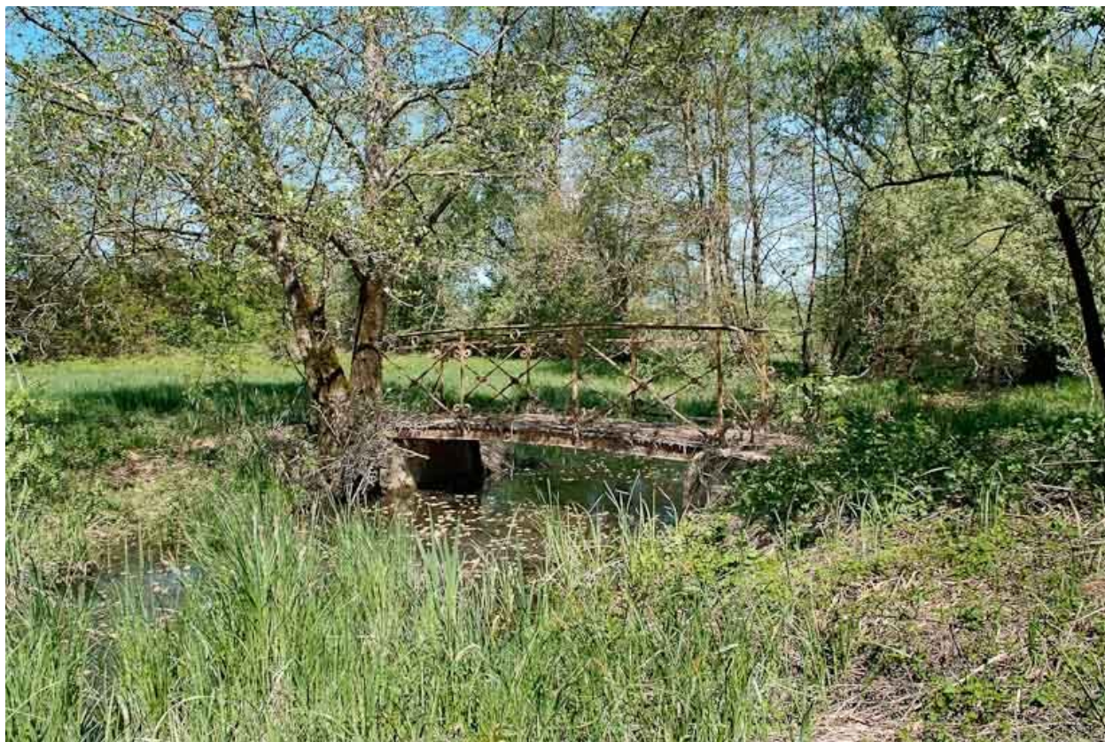
Passerelle métallique sur le Bief Michaud.
