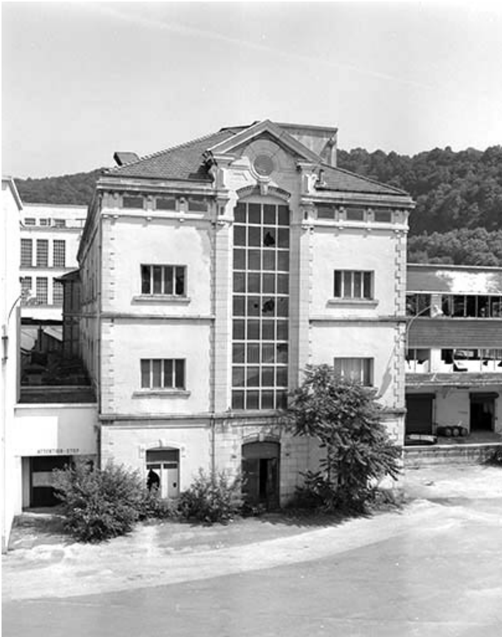
Façade de la cantine (T1, ancien atelier de fabrication).
