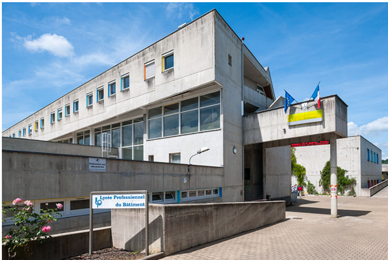
Entrée du lycée Le Corbusier: bâtiment administration
