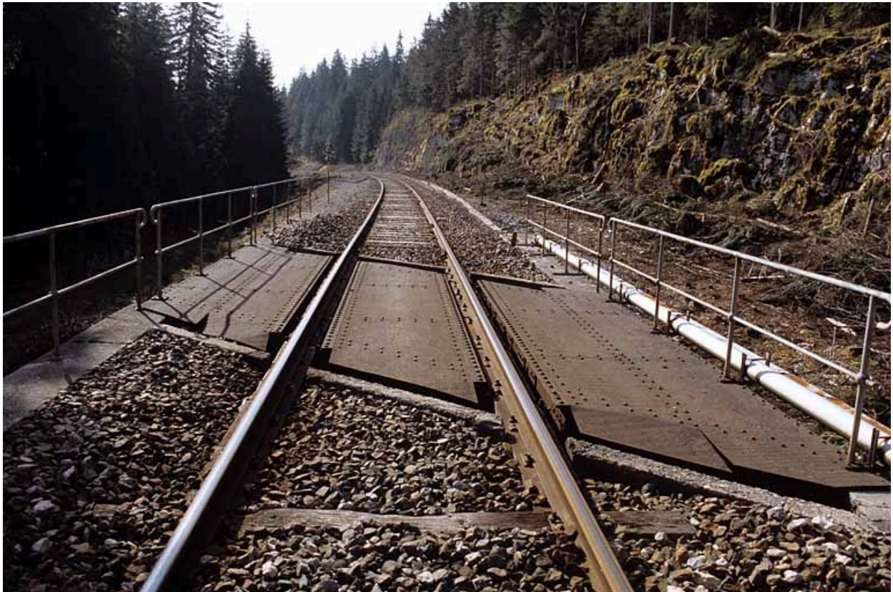
Tablier métallique, depuis la voie côté Andelot-en-Montagne.
