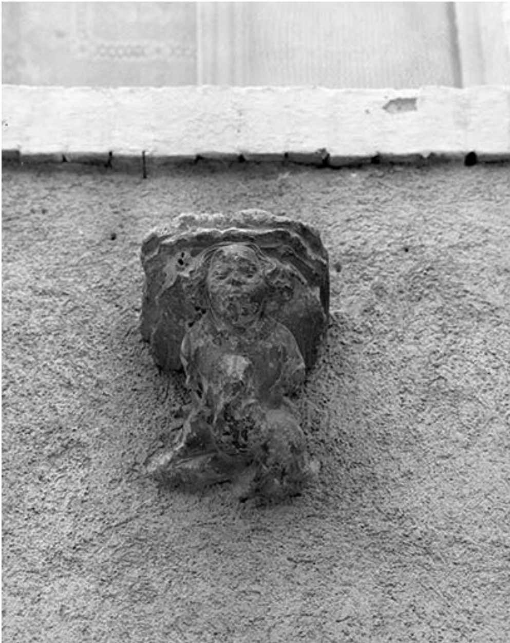
Maison cadastrée 1971 AB 348 : détail de la console (ange portant un écusson).
