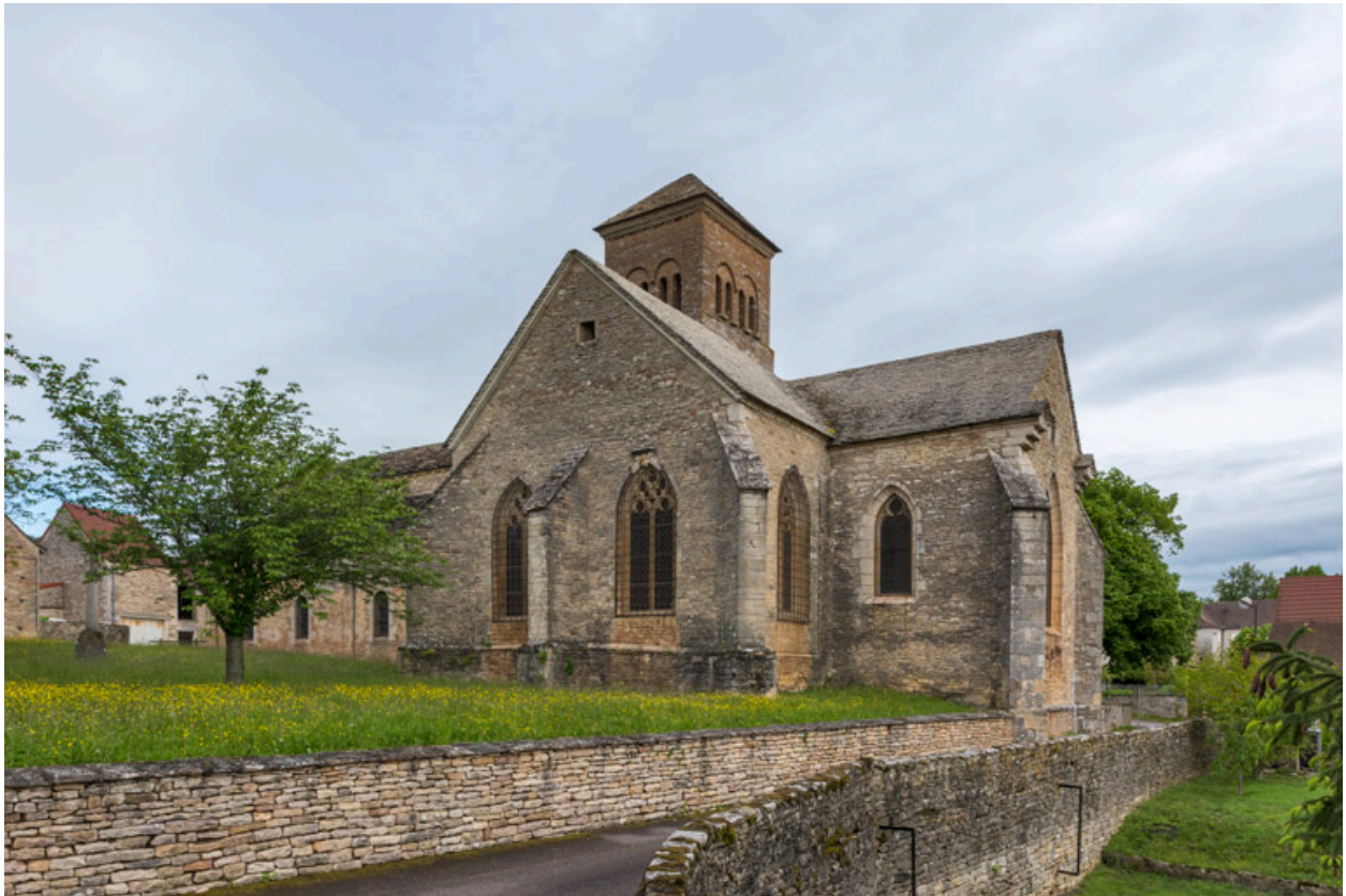
Flanc sud, avec la chapelle de Lugny et le chœur (vue depuis le sud).
