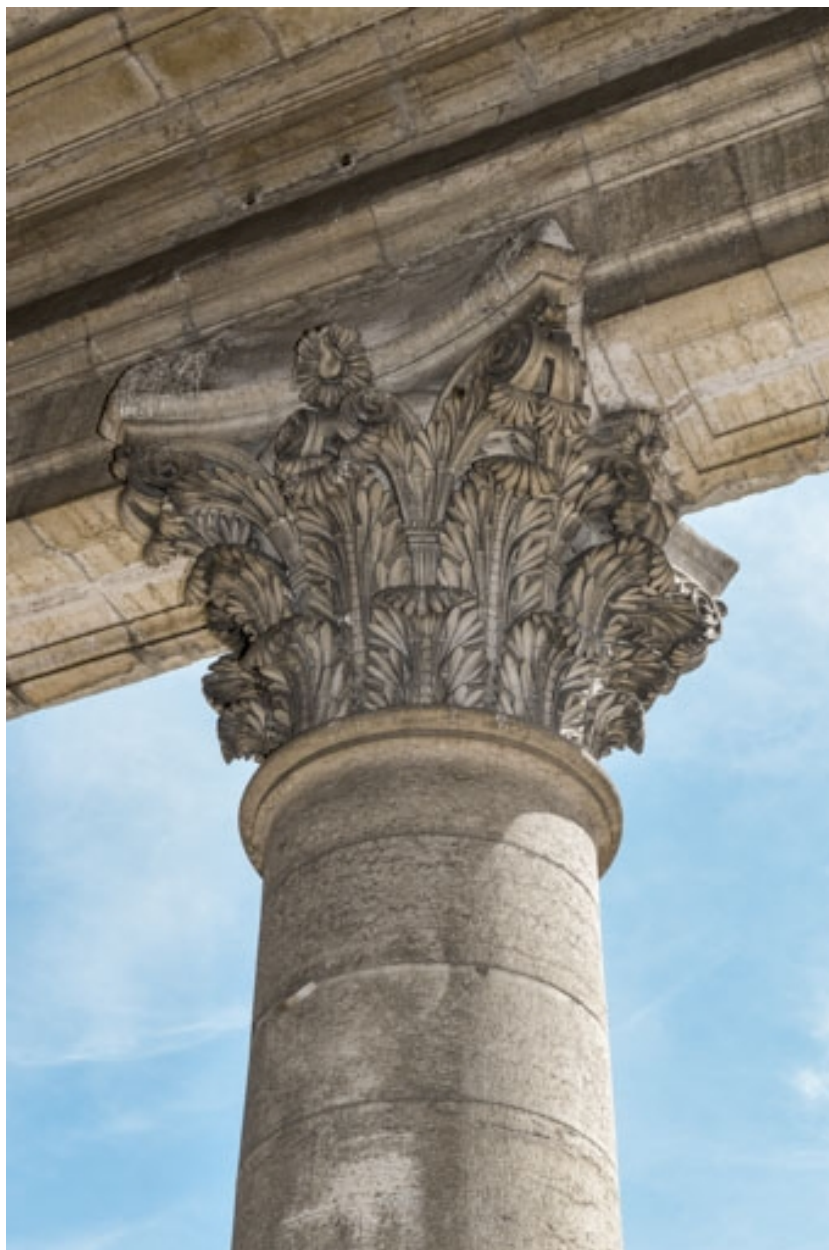
Façade antérieure : chapiteau d'une colonne.
