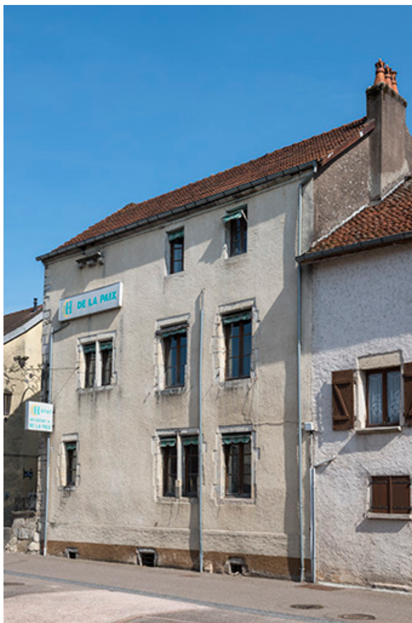
Façade rue Jean Bogé.
