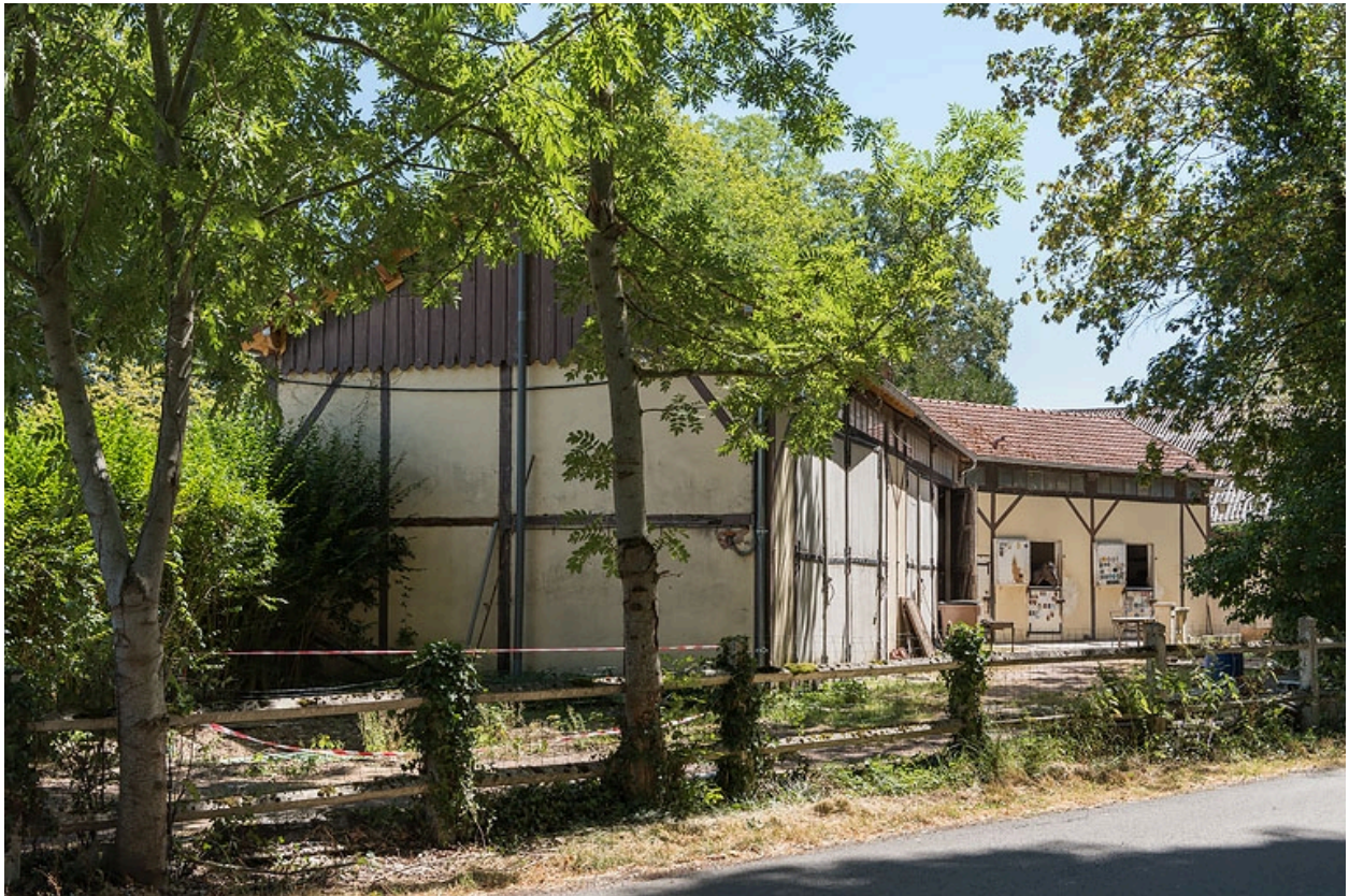
Vue depuis l'ouest.
