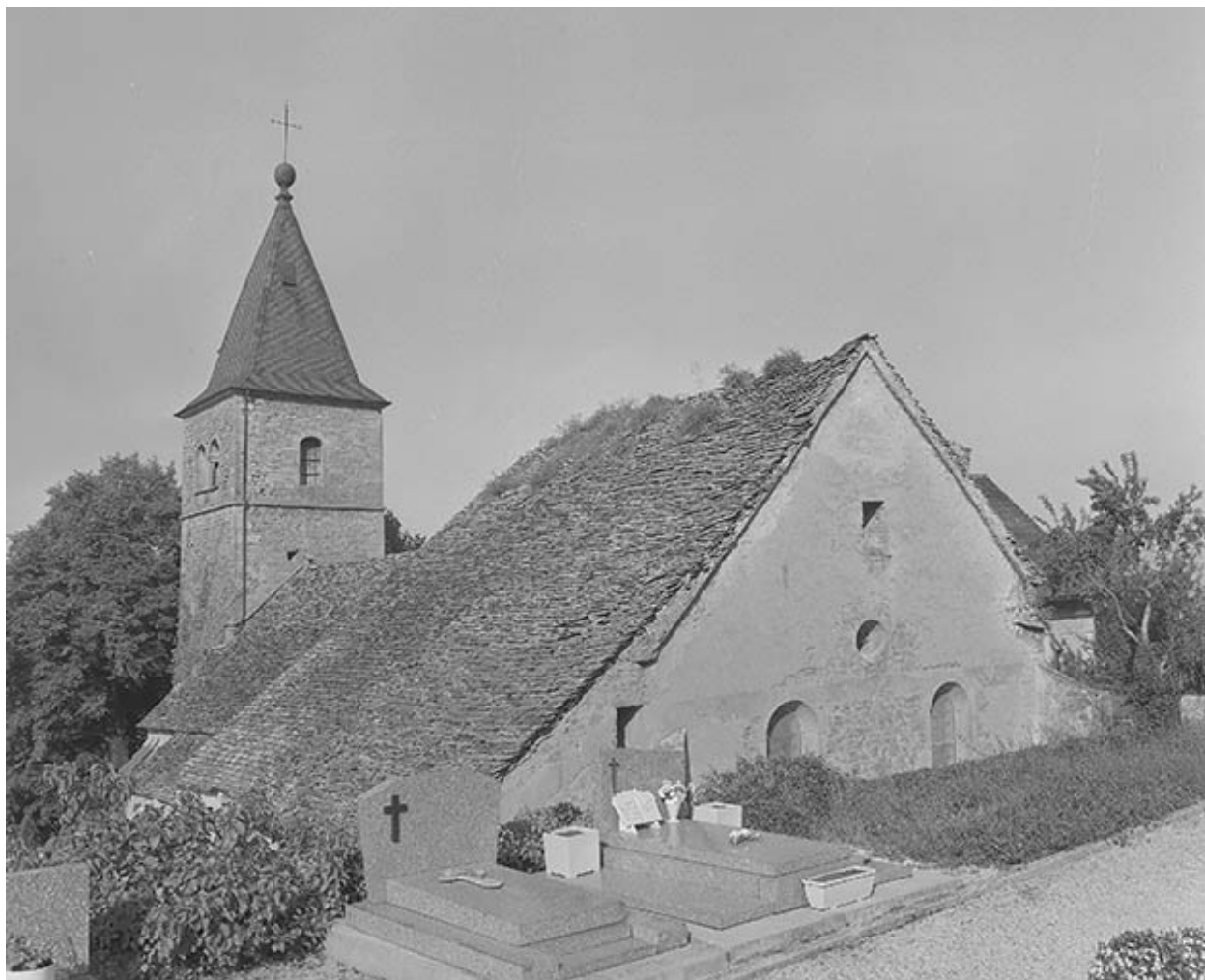
Façade latérale droite et chevet.
