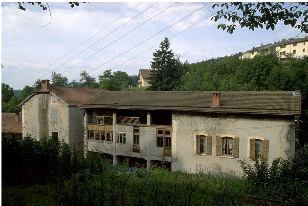
Ancienne tournerie, atelier de fabrication et logement.
