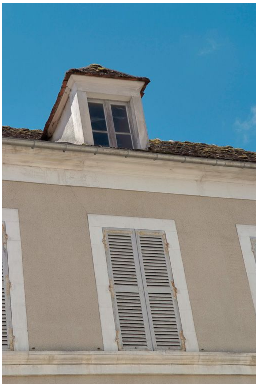
Bâtiment sud, lucarne et fenêtre.
