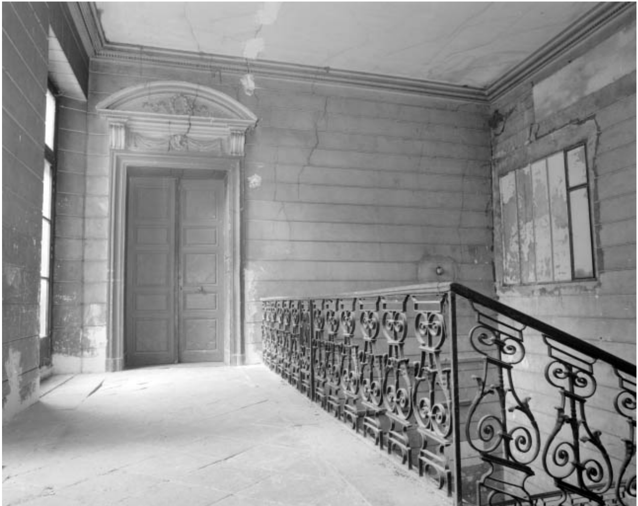
Intérieur : escalier d'honneur, vue d'ensemble du palier.
