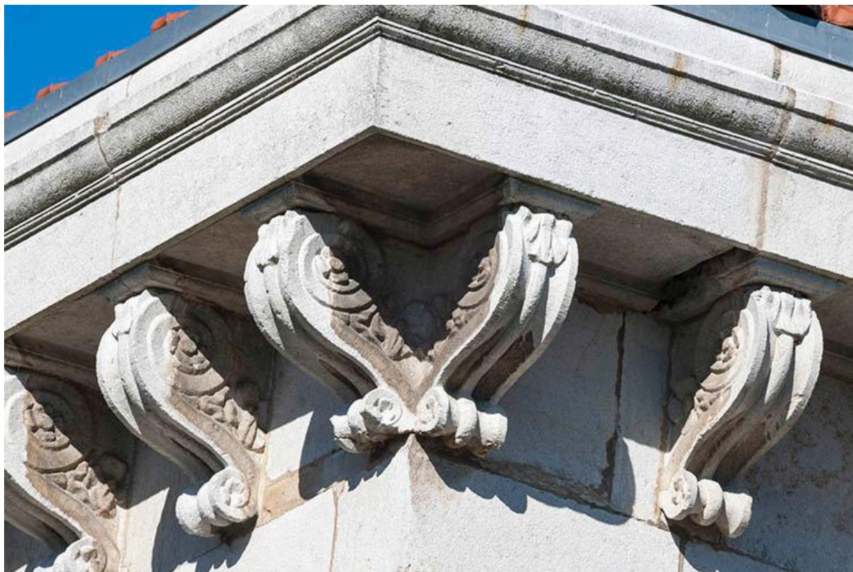
Détail de la corniche
