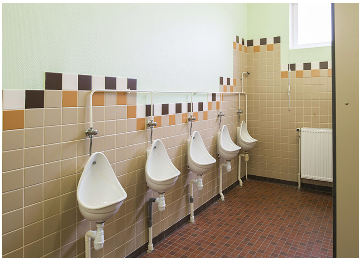
Détail intérieur dans la cantine.
