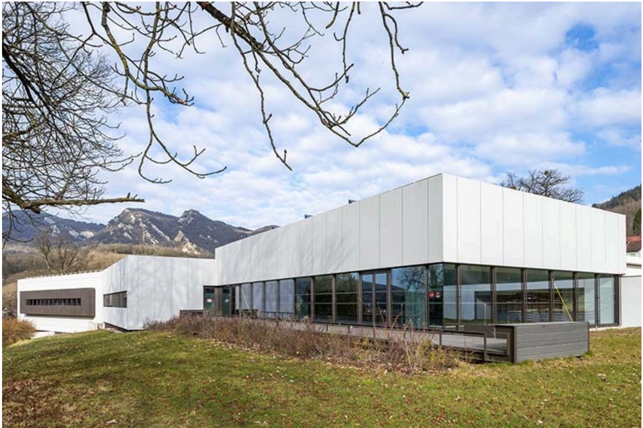
Vue depuis le sud-ouest.
