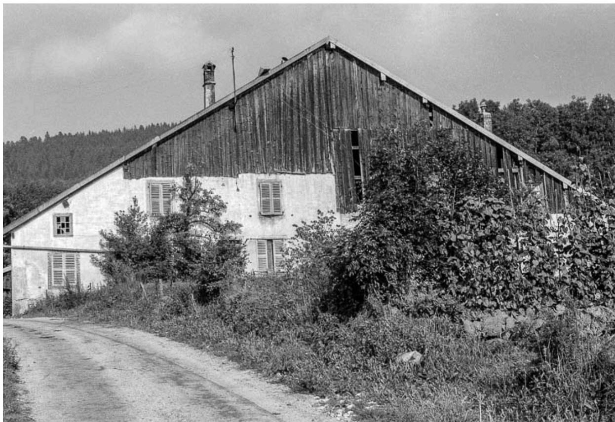
Ferme : vue d'ensemble depuis le chemin.
