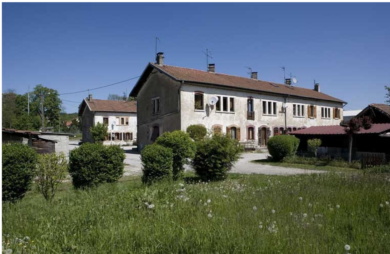
Cité ouvrière (rue Weibel). Logement collectif depuis le sud-ouest.
