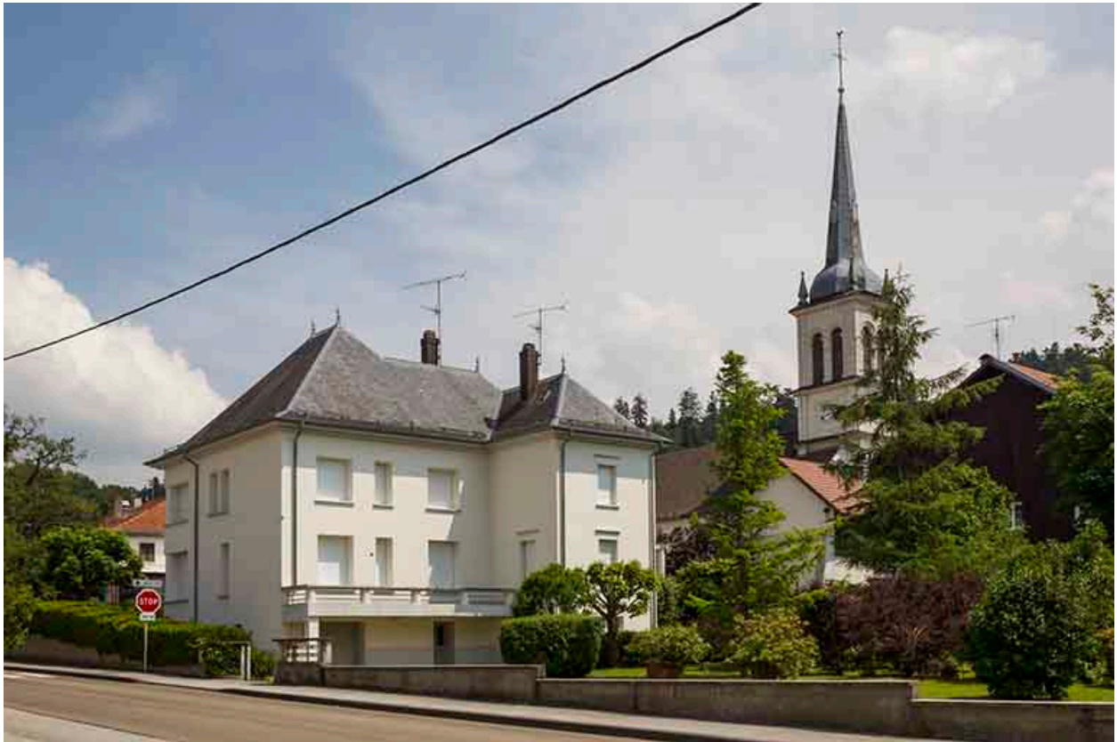
Logement patronal depuis l'ouest (façade postérieure).
