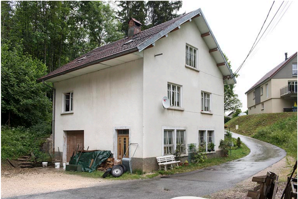
Façades sud est ouest.
