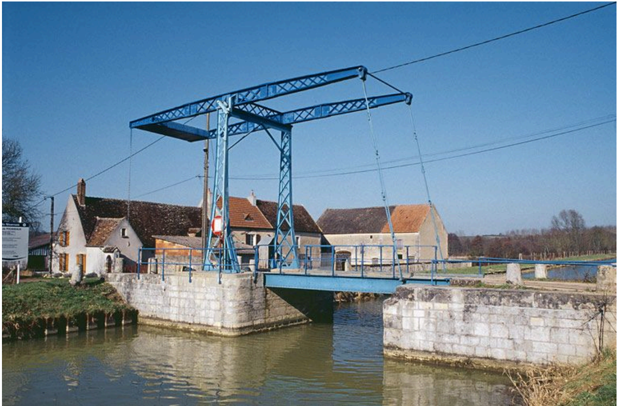
Pont mobile dit pont-levis à flèches de Pousseaux.
