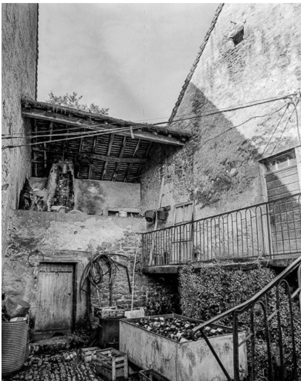
La cour entre les deux bâtiments.
