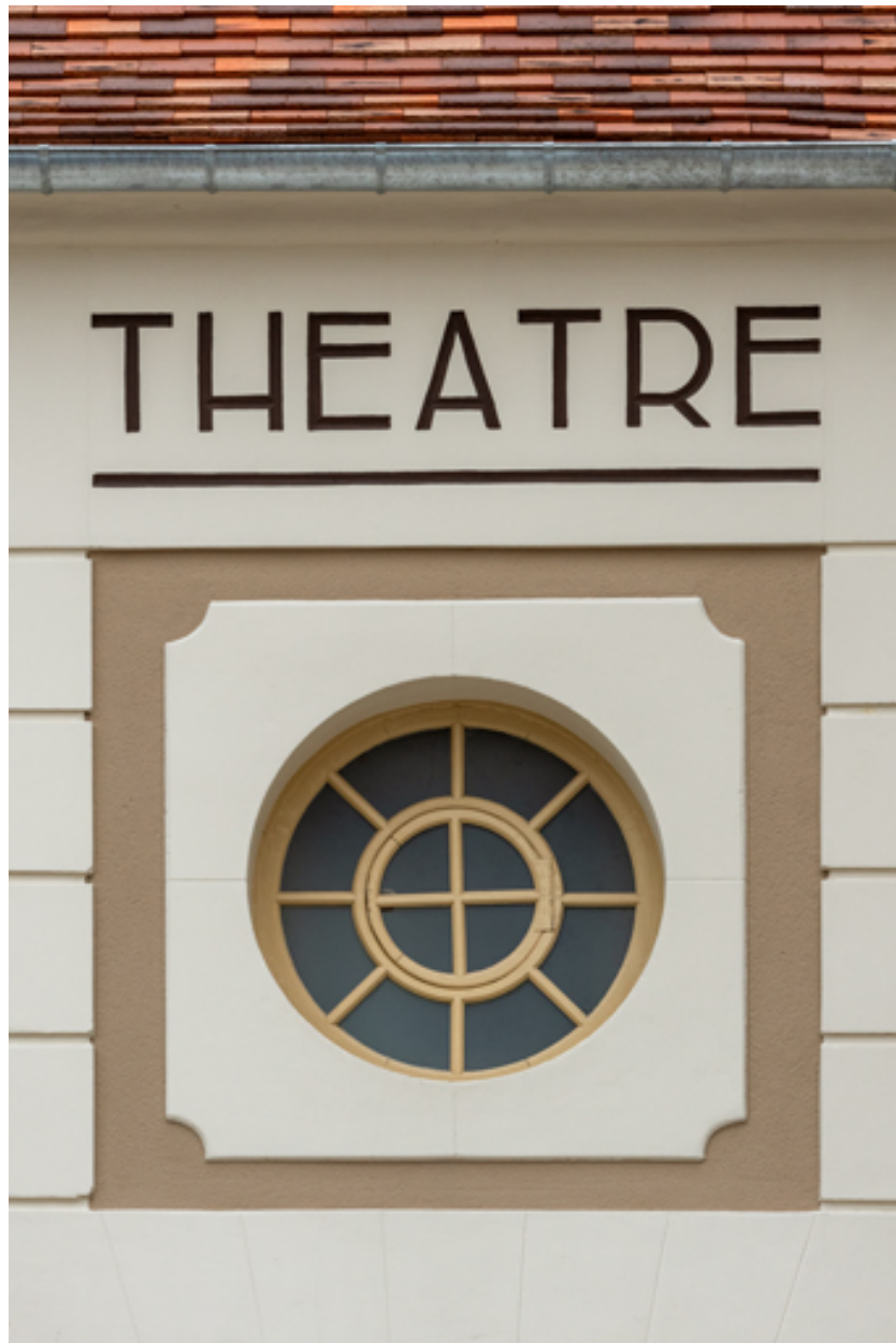
Façade antérieure : oculus.
