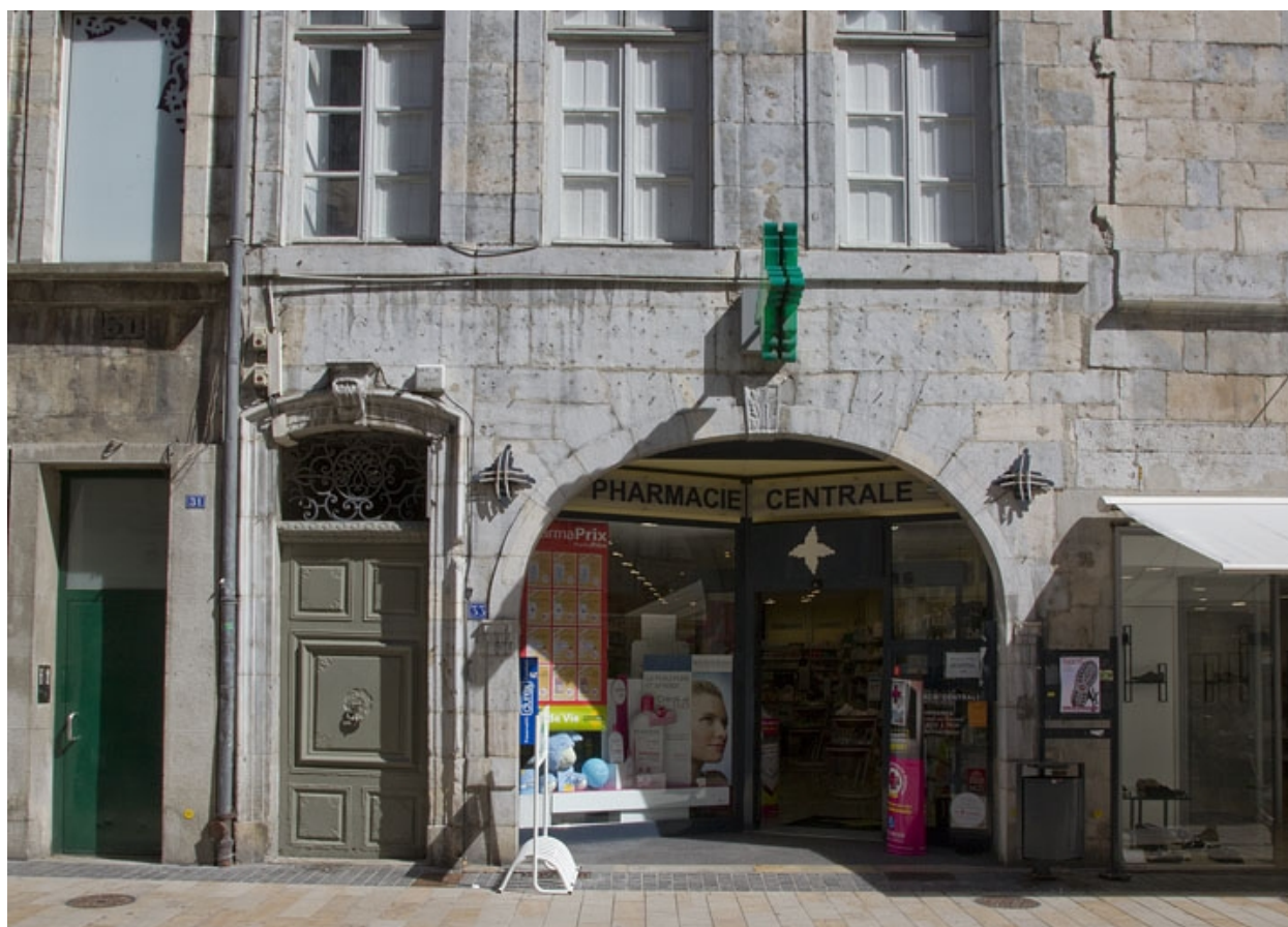
Logis principal, façade antérieure : détail du rez-de-chaussée.
