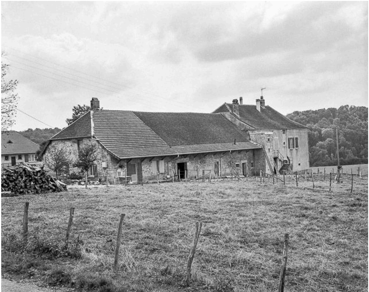
Vue générale de la face postérieure.
