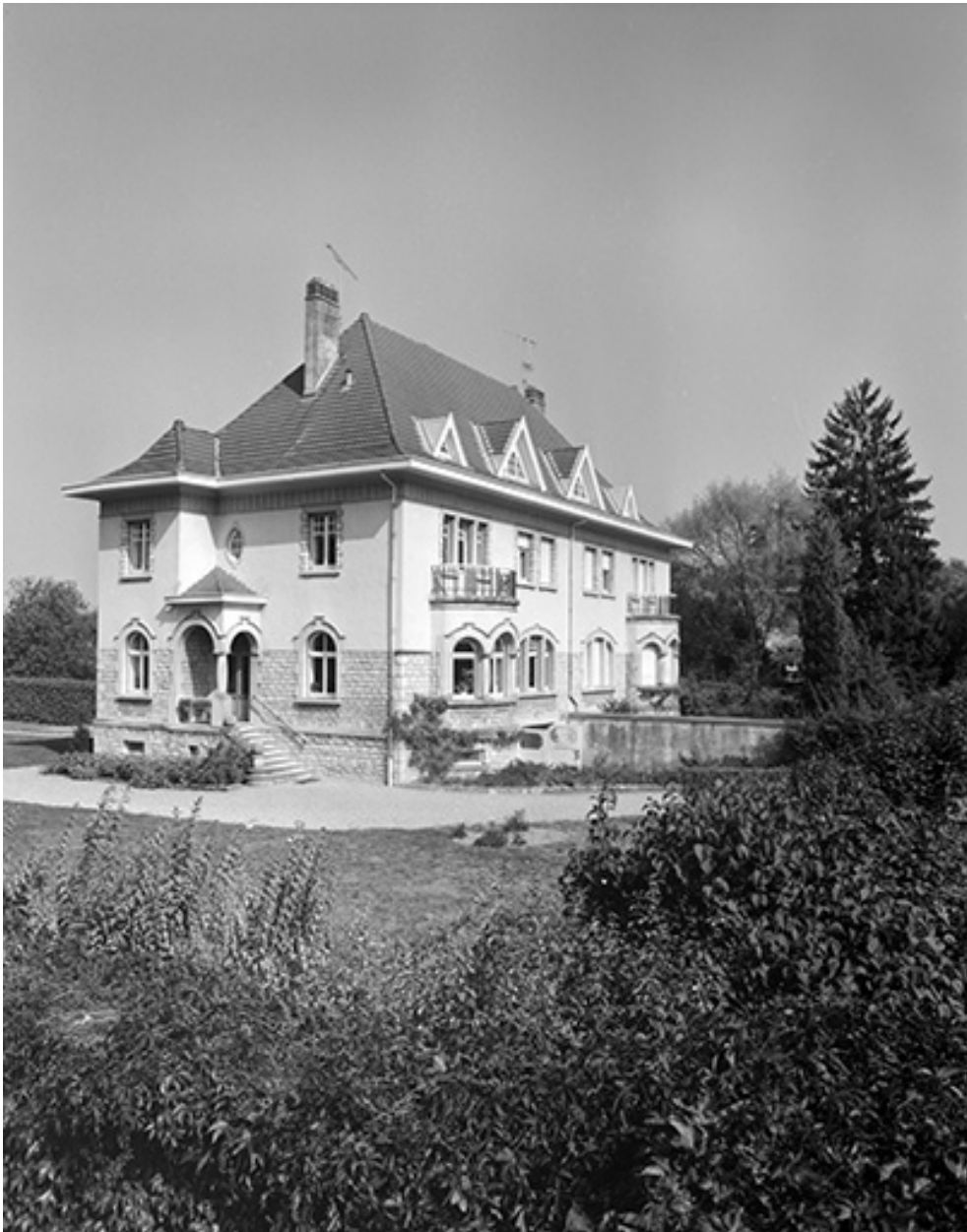
Façade antérieure et façade droite de la maison 1, 3 avenue Ernest Solvay.
