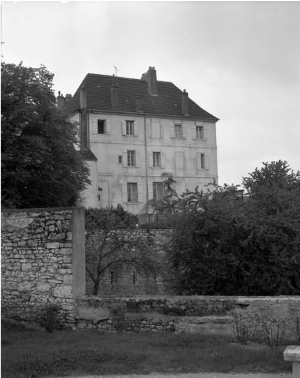
Façade latérale du bâtiment principal.
