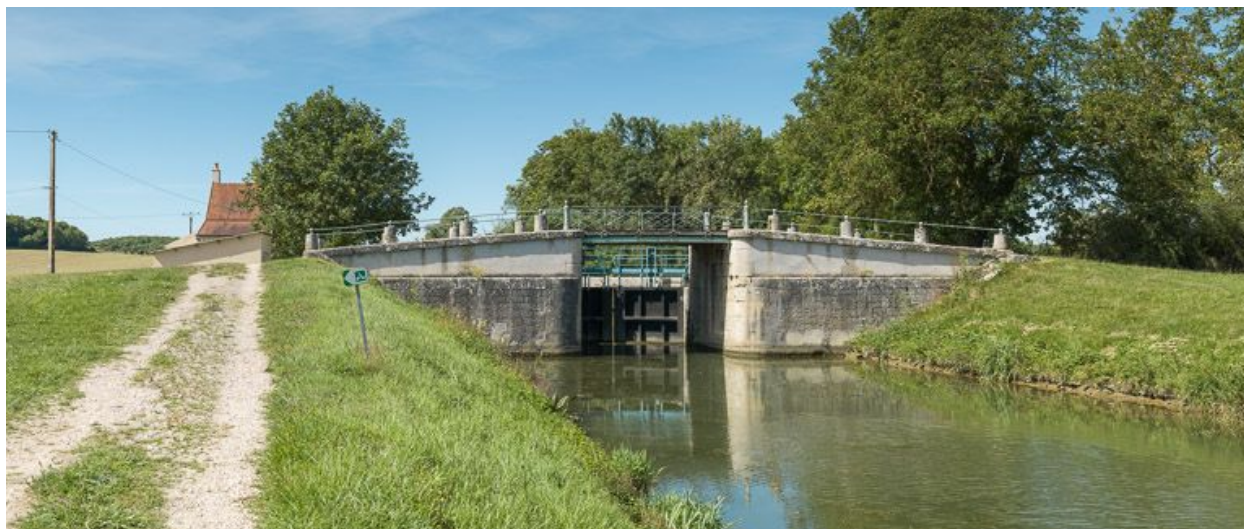
Le pont, vu d'aval.
