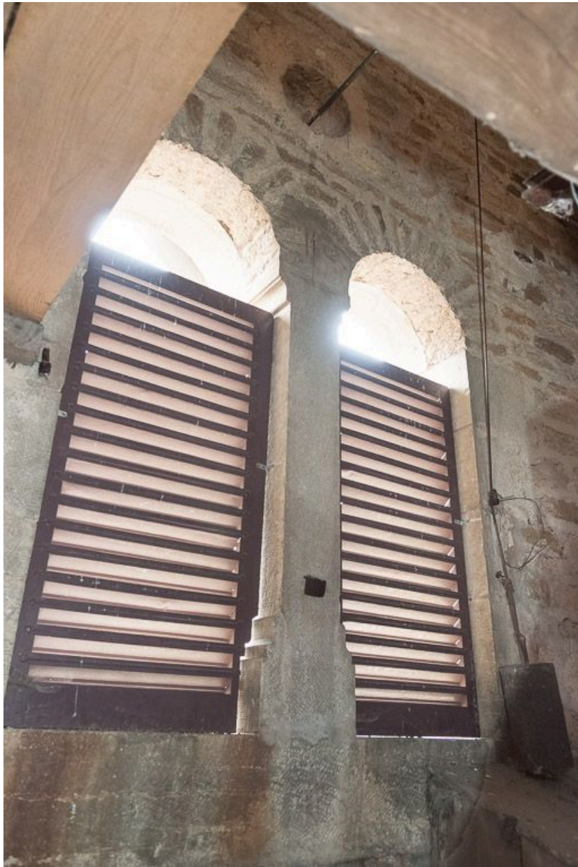
Baie du clocher et abat-sons.
