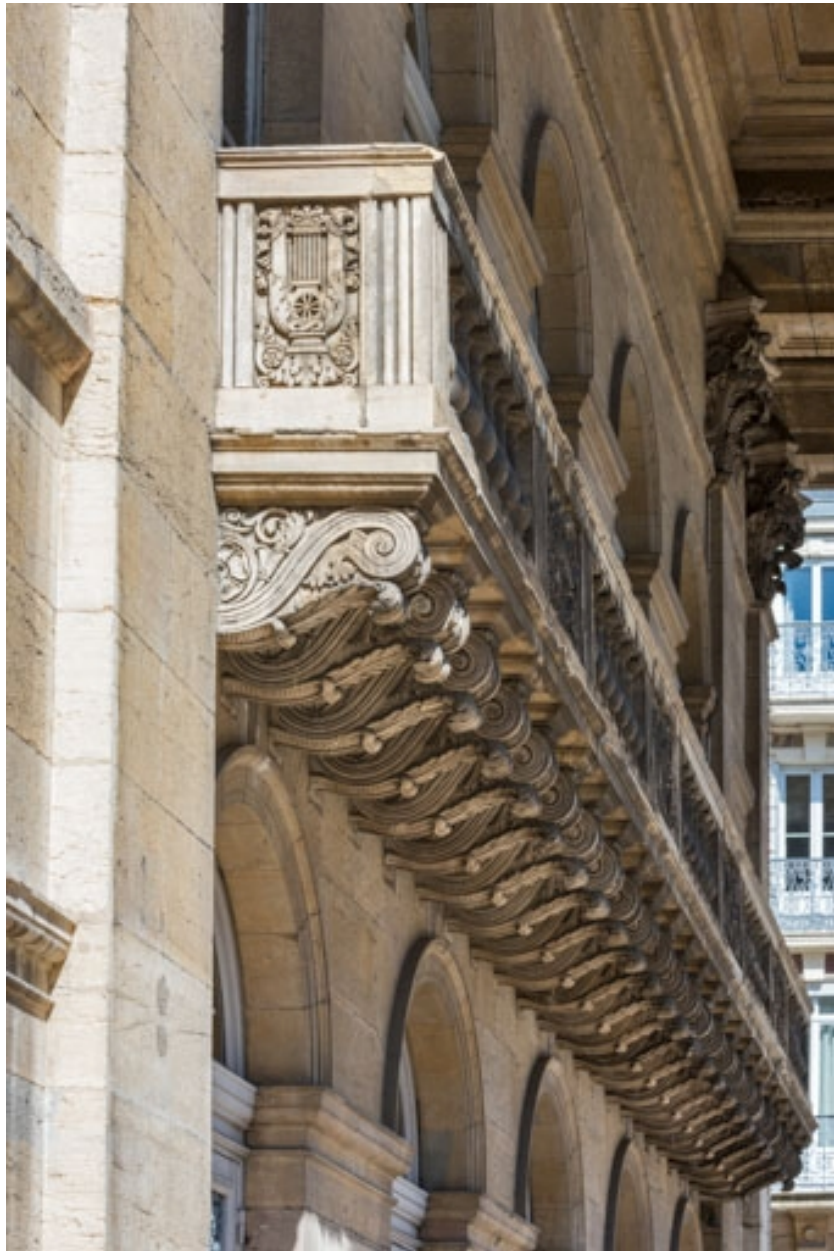
Façade antérieure : balcon, vu en enfilade.
