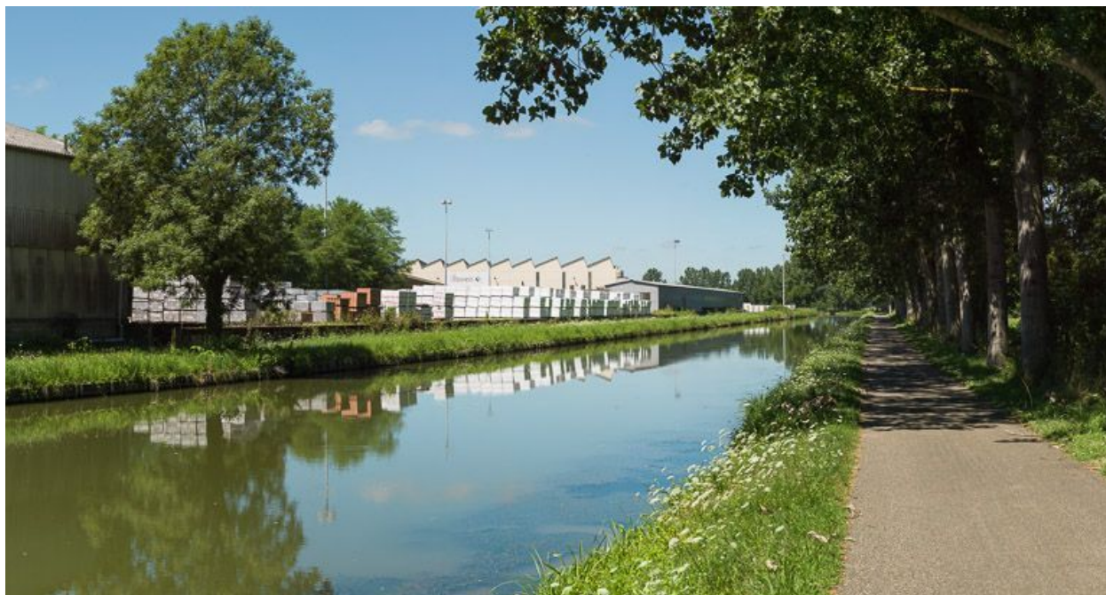
Vue d'ensemble d'amont.
