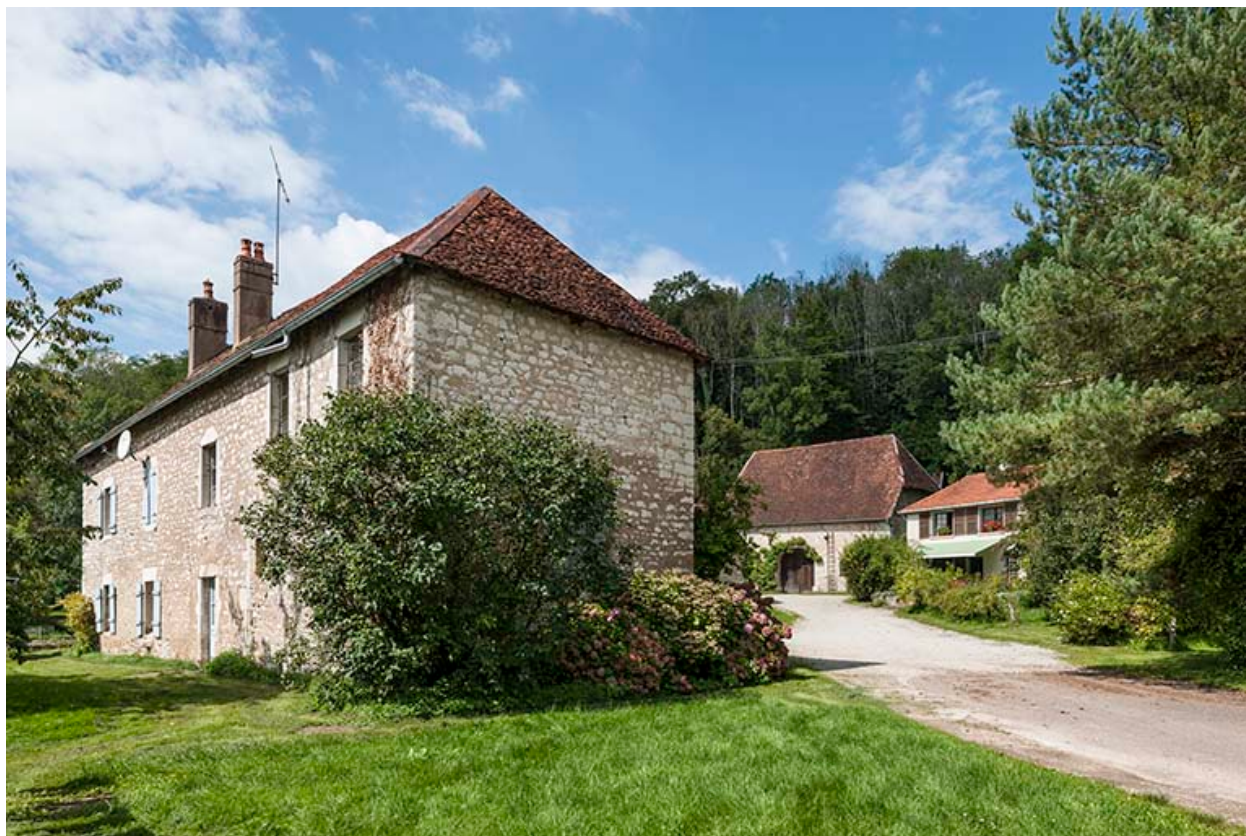
Vue d'ensemble depuis l'entrée du site.
