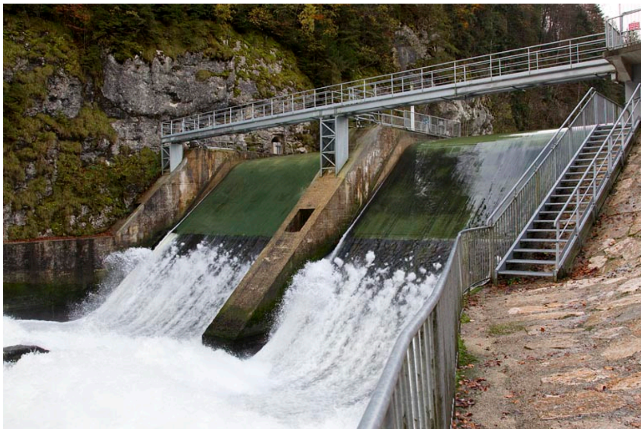
Barrage vu de trois quarts, depuis l'aval.
