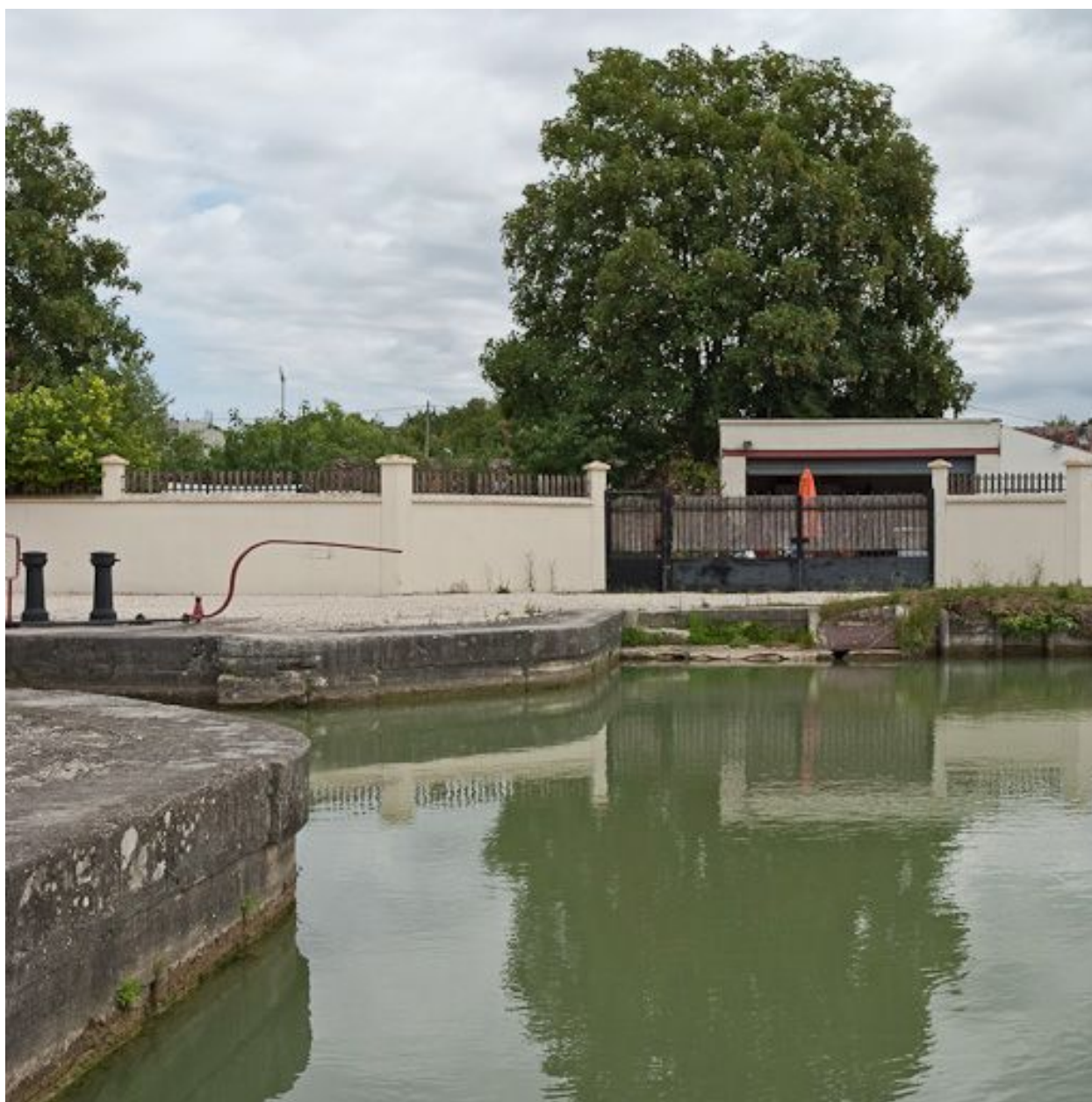
Vue du lavoir de la maison.
