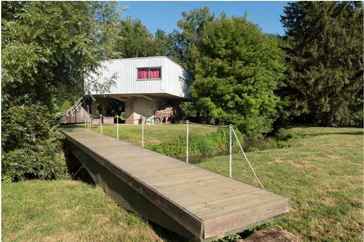
La villa et sa passerelle, angle sud-est
