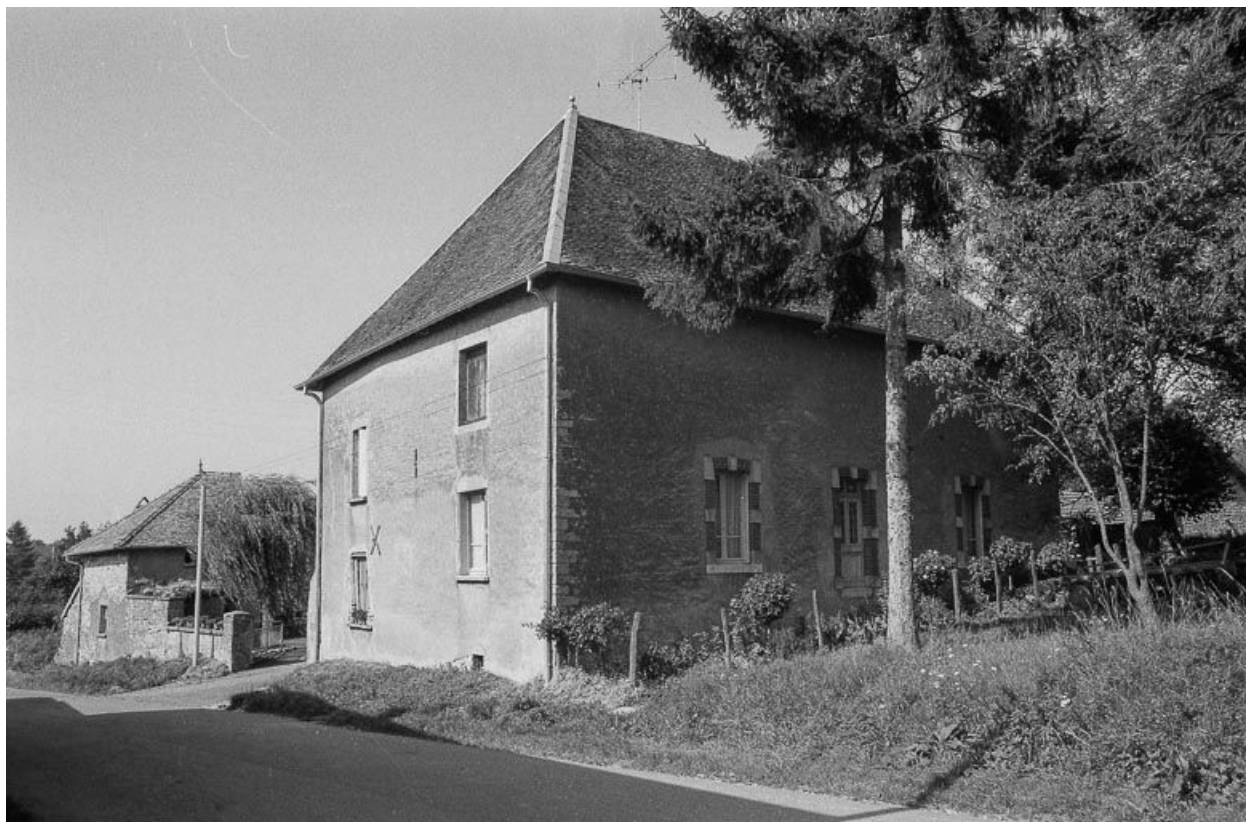
Villers-Chemin-et-Mont-lès-Etrelles : maison située à Mont-lès-Etrelles.
