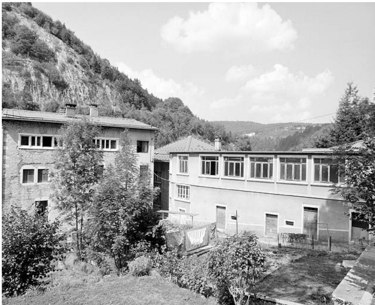
Atelier à fenêtres lunetières (à gauche, au 39 rue de la République) et usine à fenêtres d'atelier (à droite, au 37 bis).
