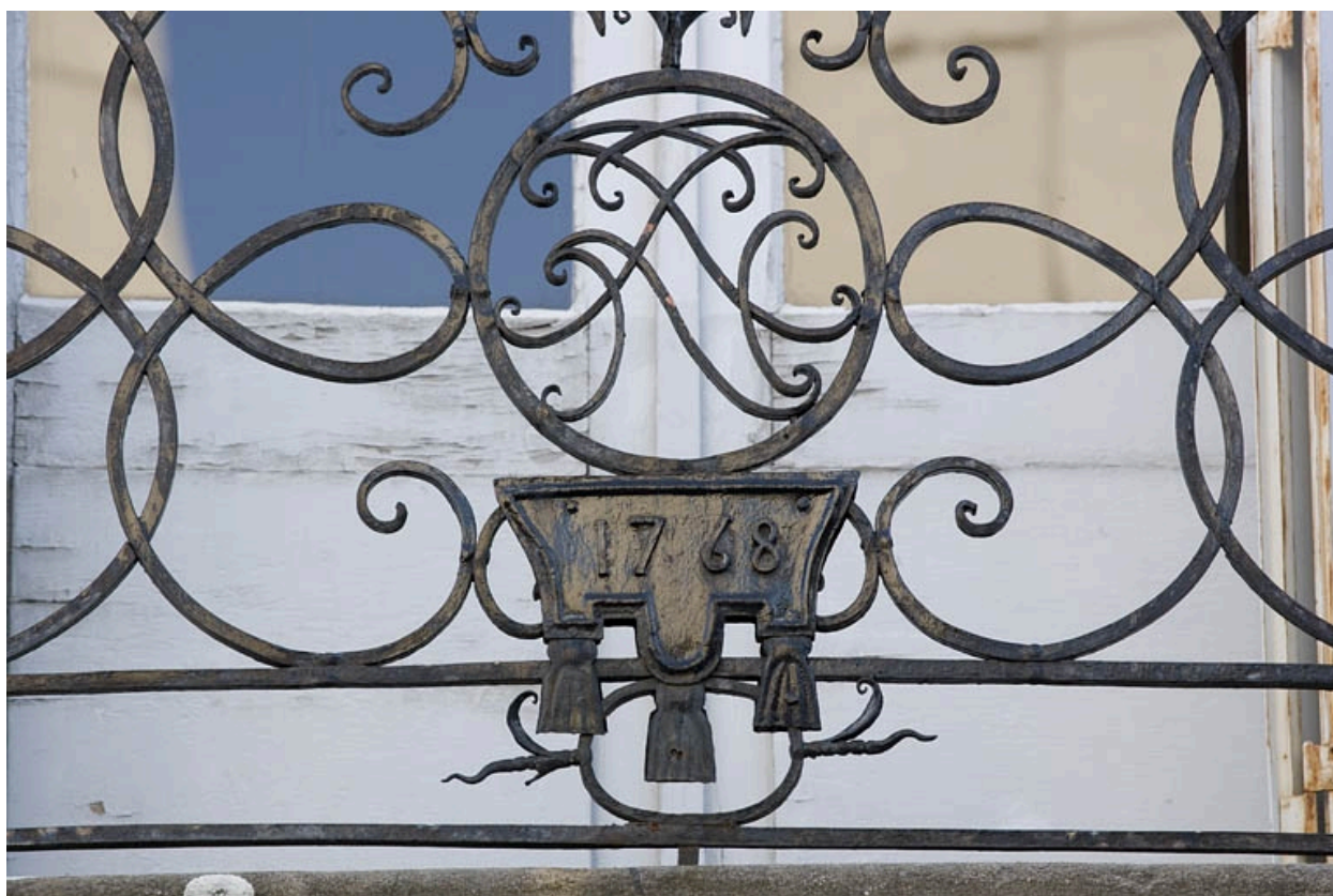
Détail de la date dans la ferronnerie du balcon.
