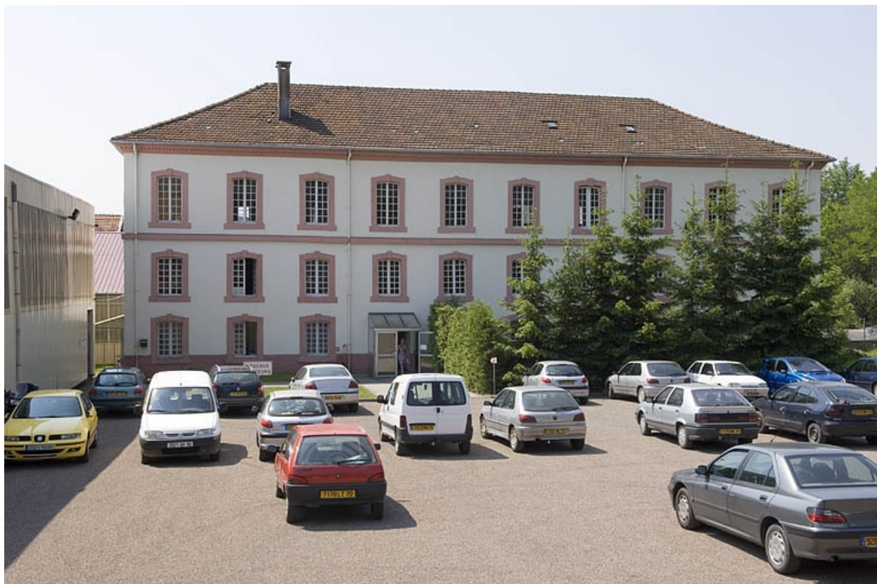
Immeuble de bureaux.
