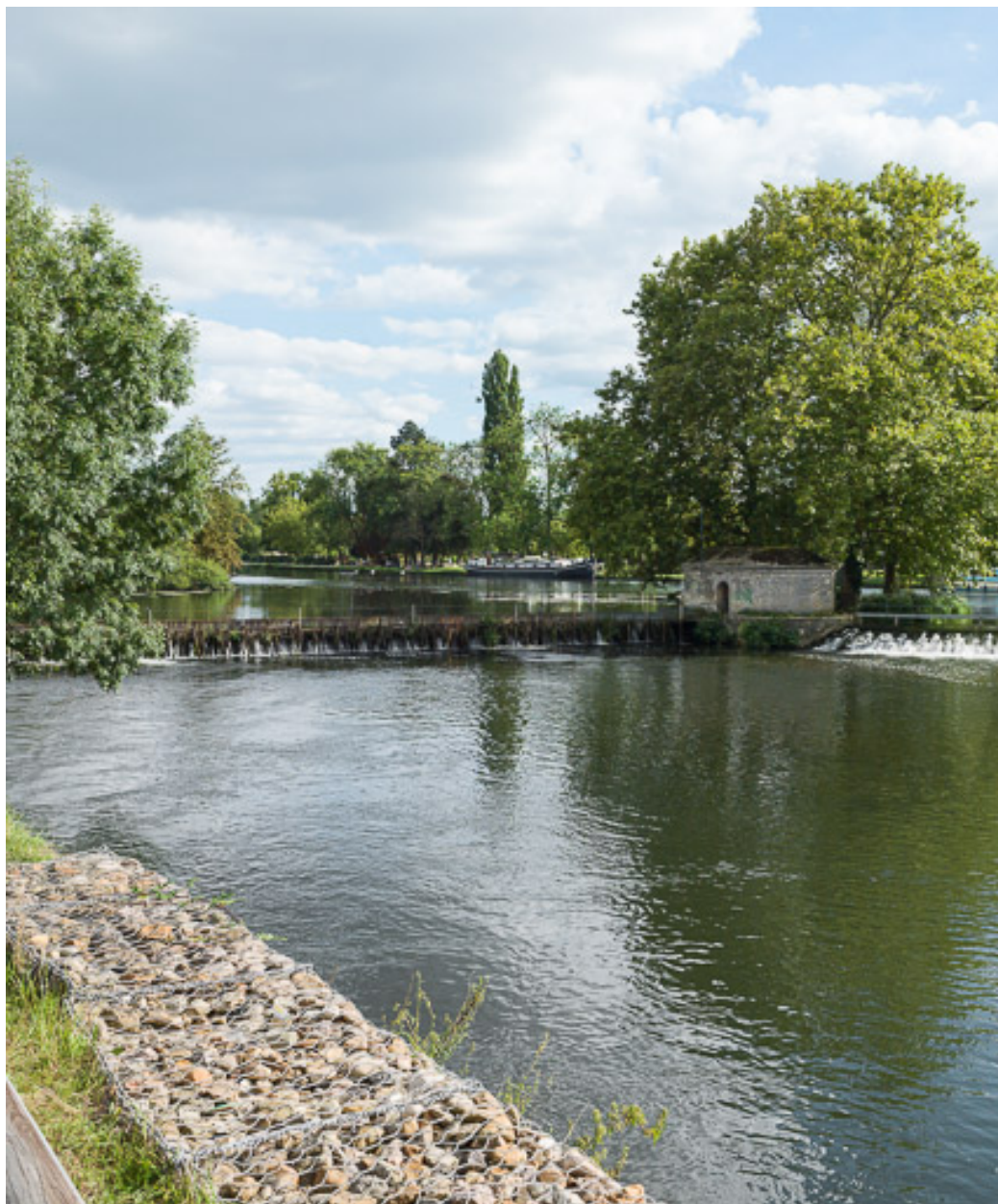
Vue du barrage.
