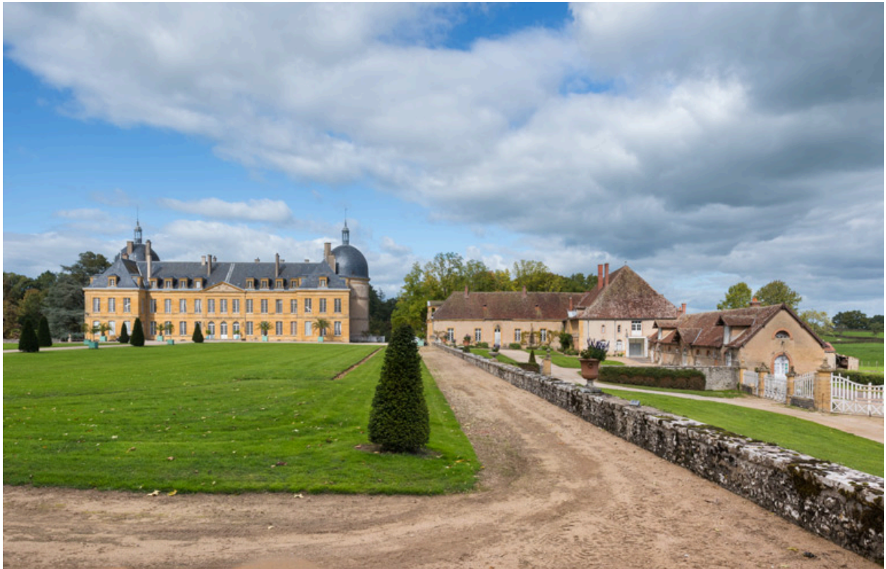
Vue d'ensemble du château de Digoine et de ses dépendances, depuis le sud.
