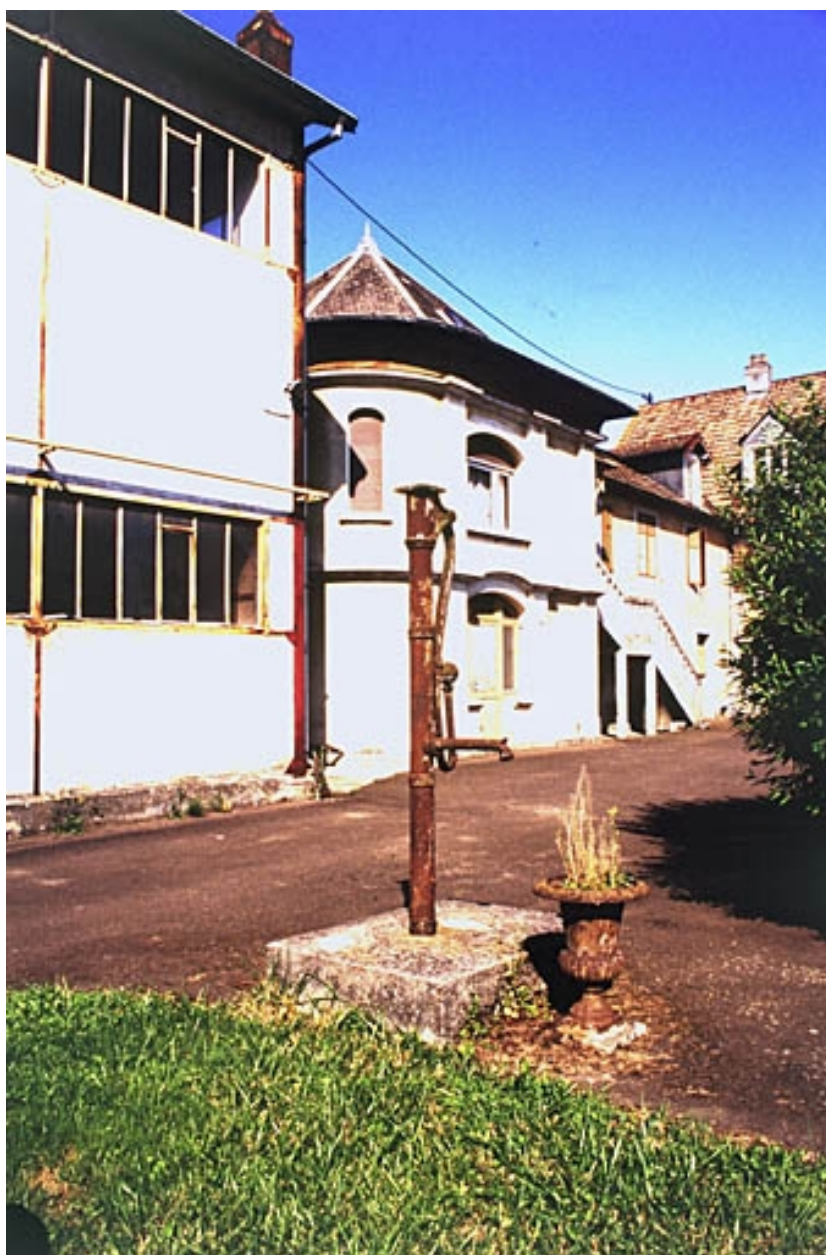
Atelier et logement depuis l'est.
