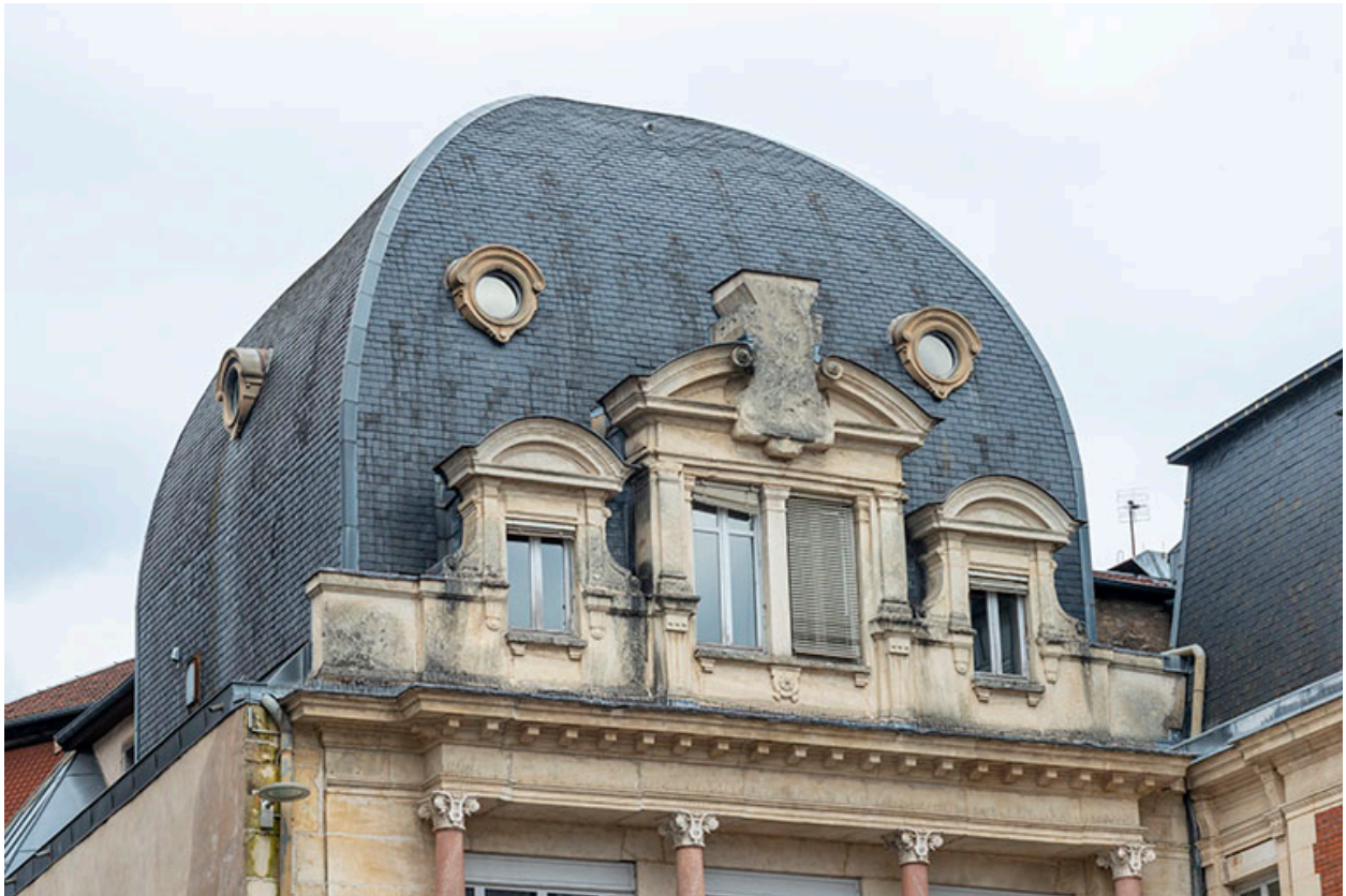
Bâtiment d'entrée, façade antérieure : dôme, vu de trois quarts gauche.
