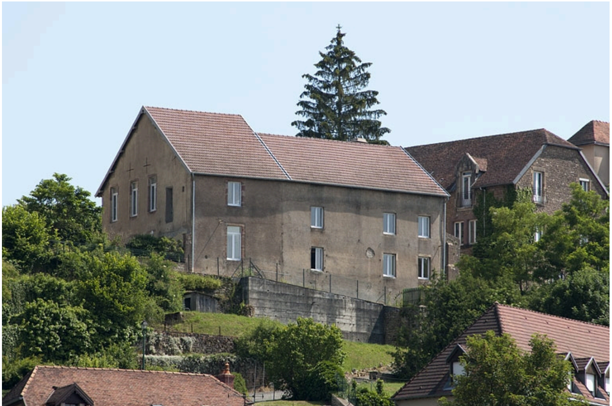
Bâtiment (B), vue générale côté village.
