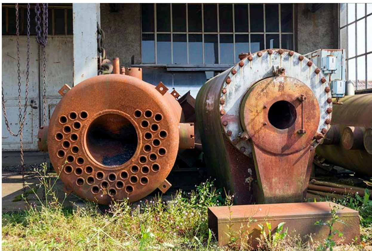
Site rue du Contremont : chaudières à vapeur.
