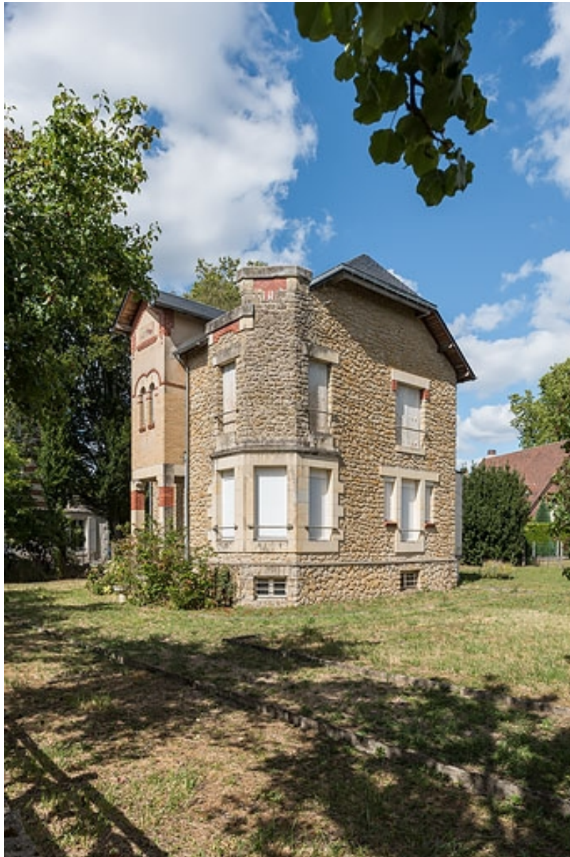
Vue depuis le sud-ouest.
