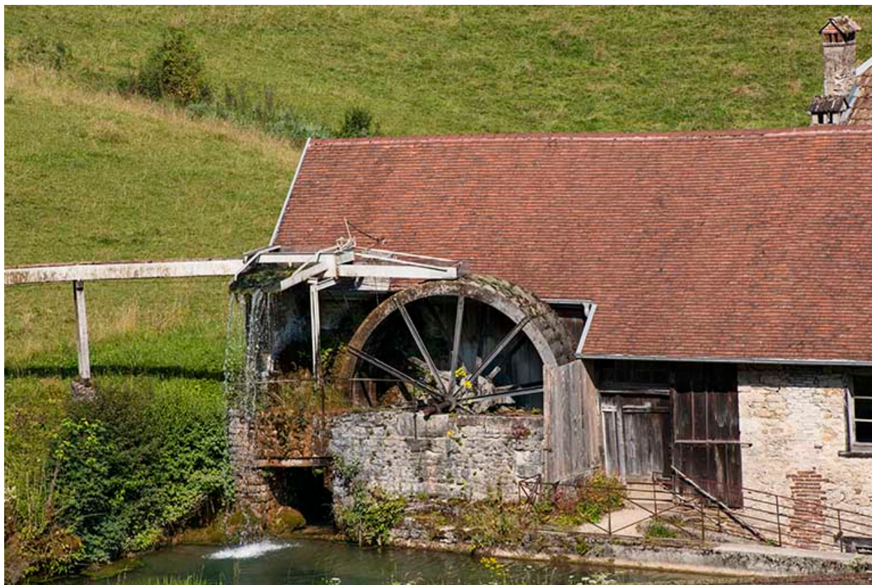
Roue hydraulique de la machine soufflante.
